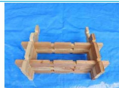
7 6の上に交差して乗る横方向の1本を、切り欠き部分を上下で合わせて置き、はめ込みます。
